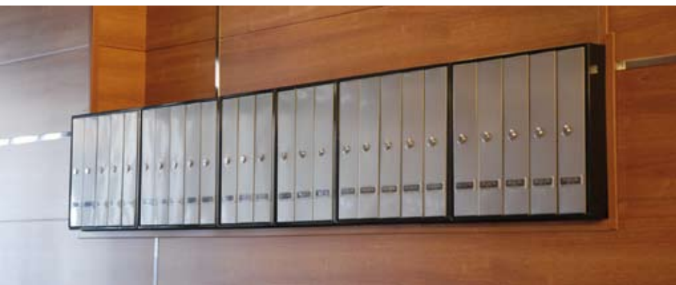
Detalle de instalación.
