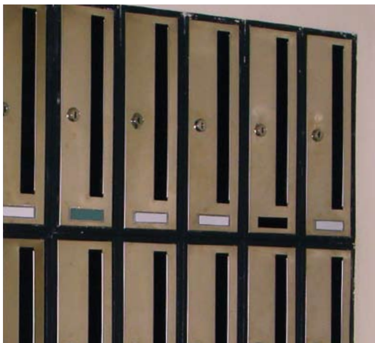
Detalle de instalación.
